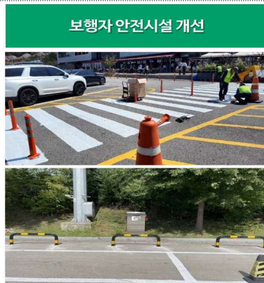
보행로 안전시설 보완 및 설치
