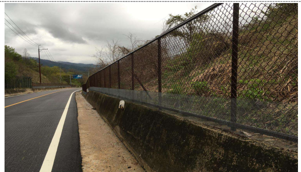
(유도울타리) 야생동물의 도로 침입 방지 또는 생태통로가 설치된 곳은 생태통로 이용 유도를 위해 설치(높이 1.5m 이상)
