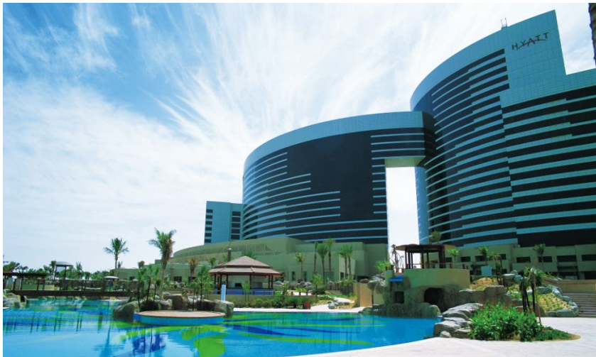
아람에미리트 B-21지구 하얏트 호텔 및 아파트 건설 사업 (1999)
