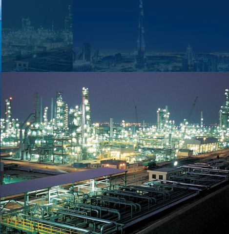
◀ 사우디 주베일 산업항만(현대건설) ▼ 이집트 미도르 정유플랜트(디엘이앤씨)
