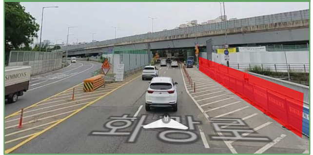
북부간선도로 화랑대사거리→묵동IC 진입로 우측
