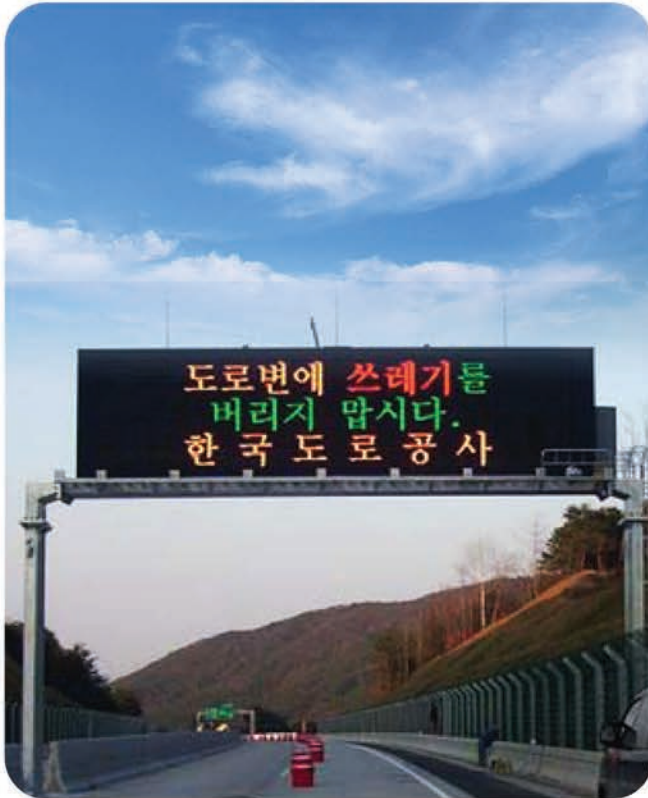
가변정보표지판(Variable Message System)
