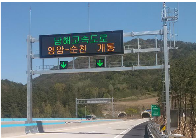
터널안내 전광판 (VMS-문형식)
