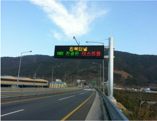
터널안내 전광판 (VMS-촉주식)
