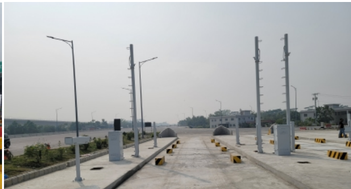
(좌)방글라데시 N8 고속도로와 (우)파드마 대교에 구축한 과적단속시스템(WIM)
